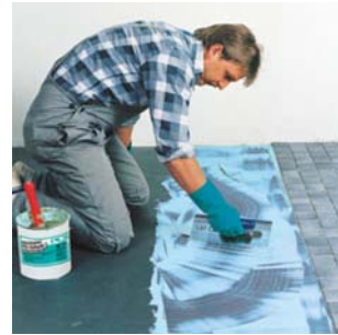
PCI COLLASTIC ® klijus galima naudoti ant plieninių pagrindų.
