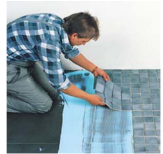
Ant dantytu glaistikliu juostelėmis išvagotų klijų suklijuoti plyteles ir jas išlyginti.
