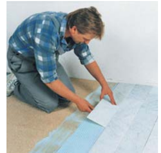
Specialiais plytelių klijais PCI COLLASTIC ® galima klijuoti marmurą ant medžio drožlių plokštės.
