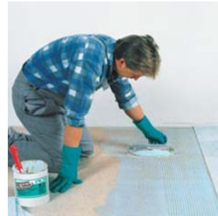
PCI COLLASTIC ® tinkamas naudoti ant drėgmei jautrių pagrindų, tokių kaip medžio drožlių plokštės.
