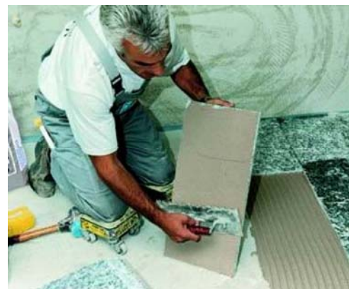
Klijuojant be oro tuštumų po plokšte skiedinį taip pat tepti ant neapdailinio plokštės paviršiaus.
