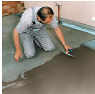
Užnešti antrąjį ir jei reikia trečiąjį sluoksnį, maksimaliai iki 5 mm sluoksnio storio, kai tik prieš tai užneštas sluoksnis nelips, tačiau dar bus pilnai nesukietėjęs.
