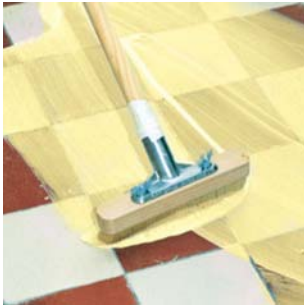
Gruntą paskirstyti ant pagrindo dviem statmenomis kryptimis.
